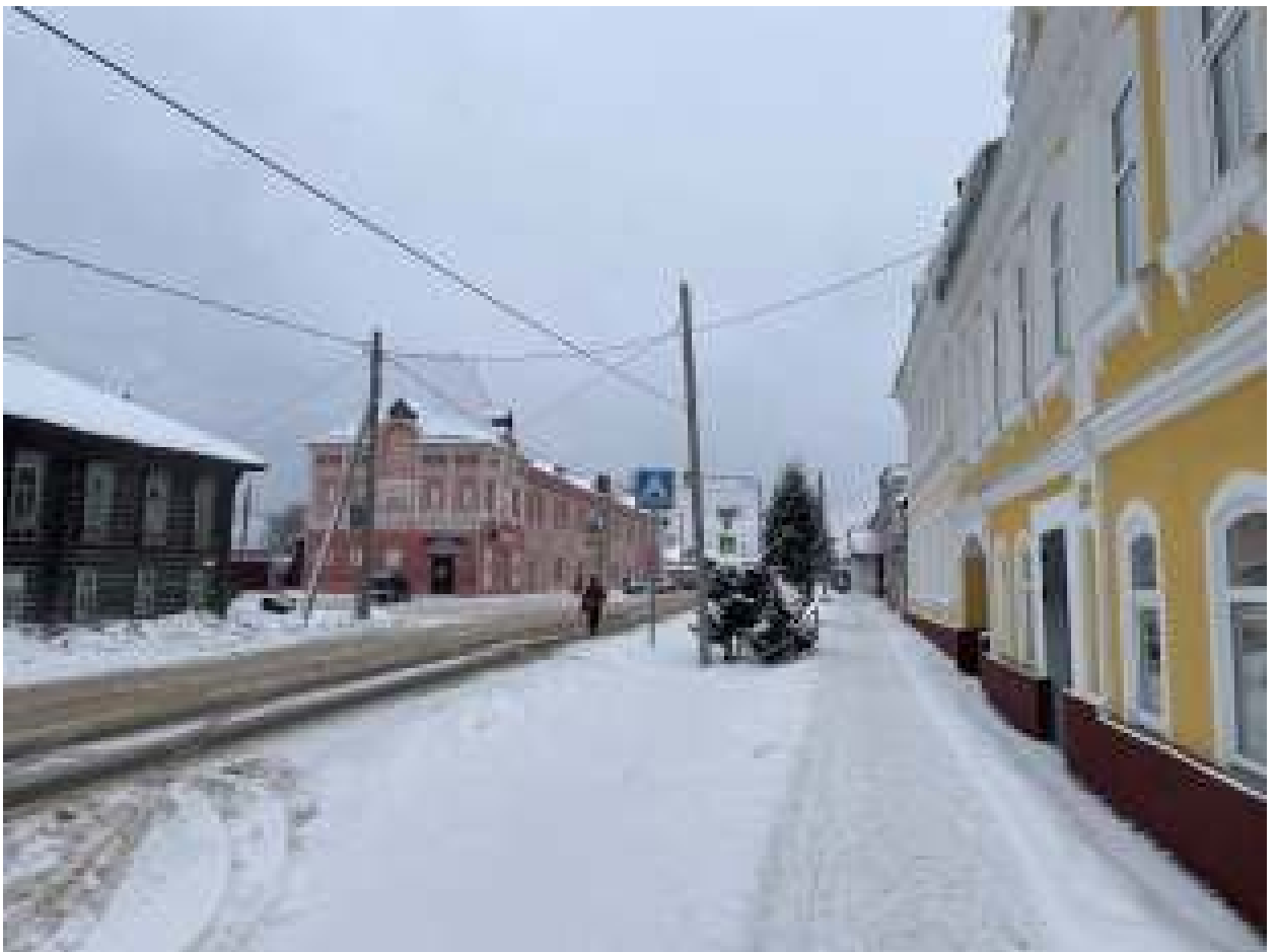
Рис. 24. Общий вид на перекресток ул. Алешкова и ул. Бахирева в г. Ветлуге Нижегородской области. Вид с северо-востока.
